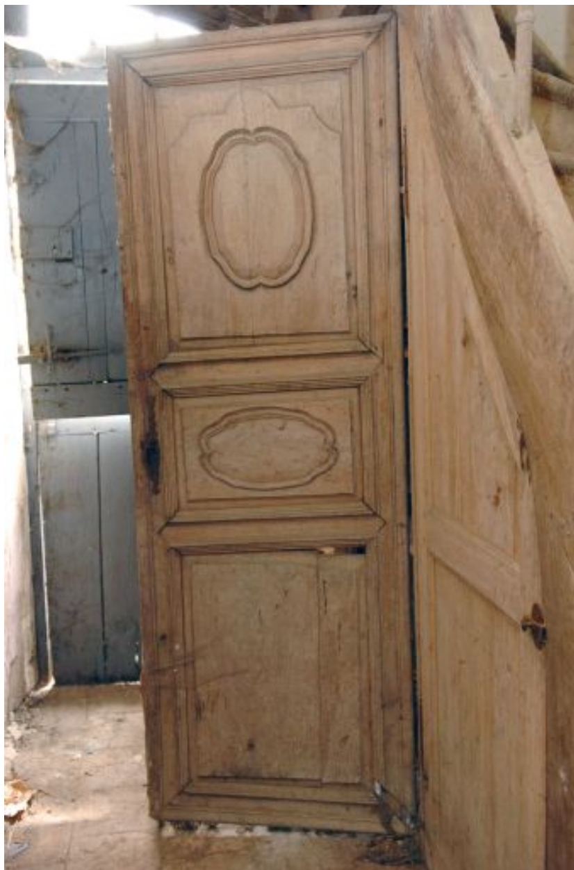
Porte d'armoire en réemploi.
