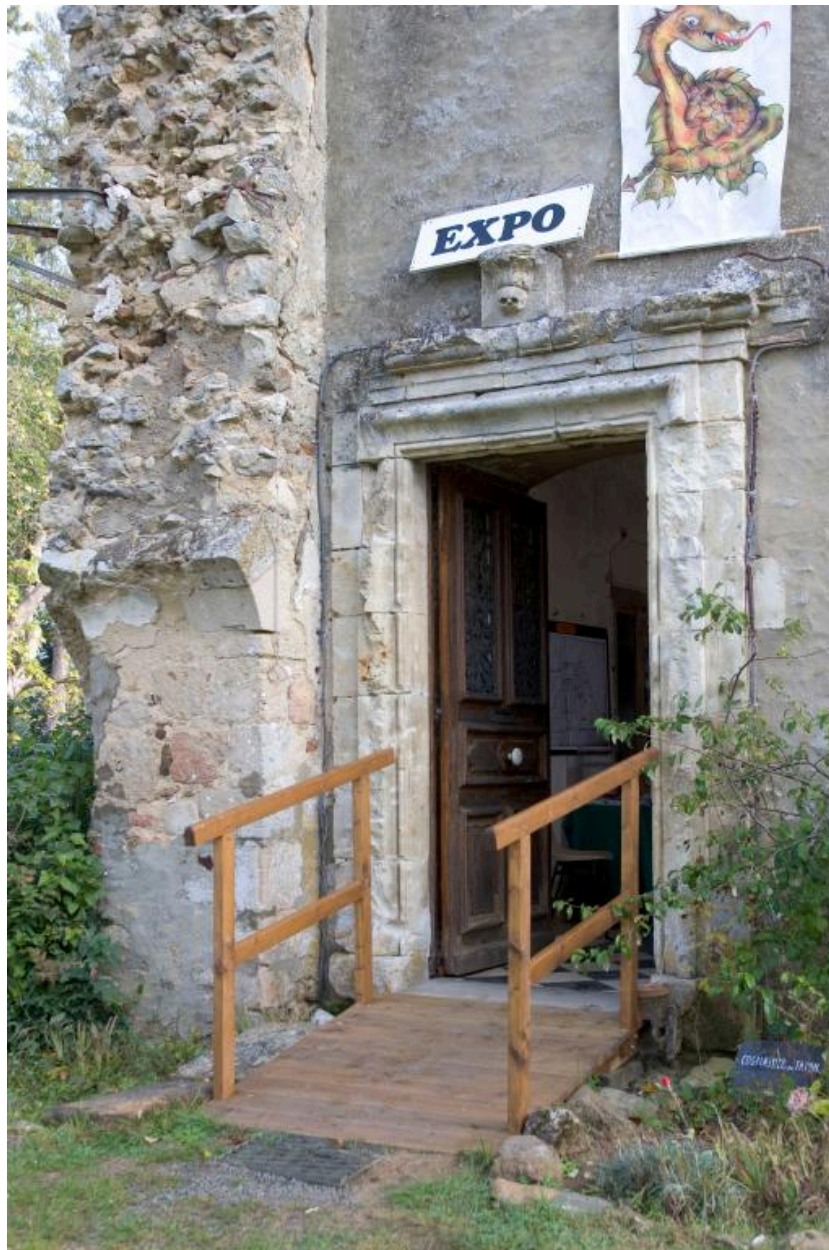
Le pavillon, façade ouest, détail de la porte, 2007.
