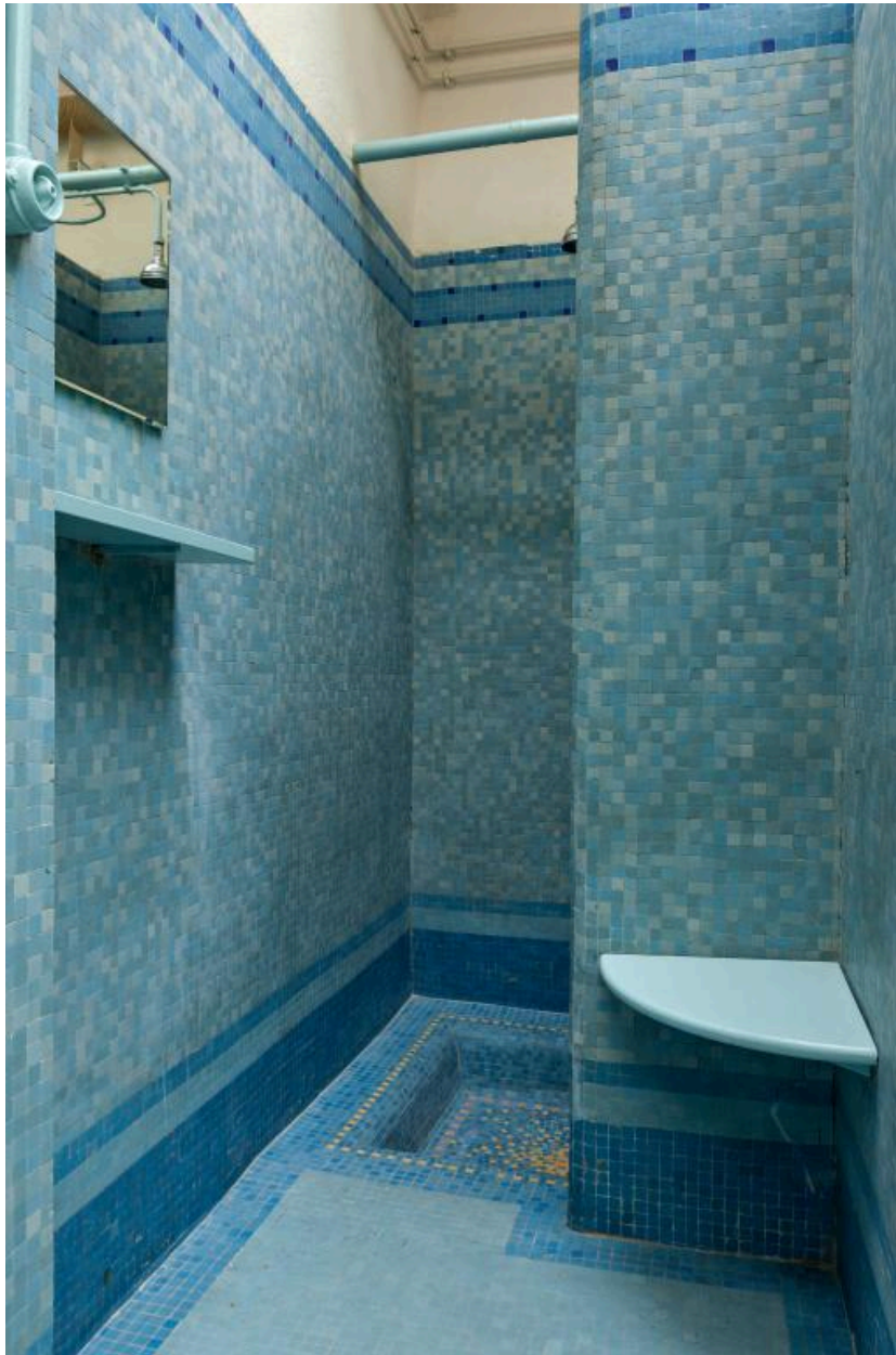
Les bains-douches restaurés. Intérieur, cabine de douches : vue d'ensemble.
