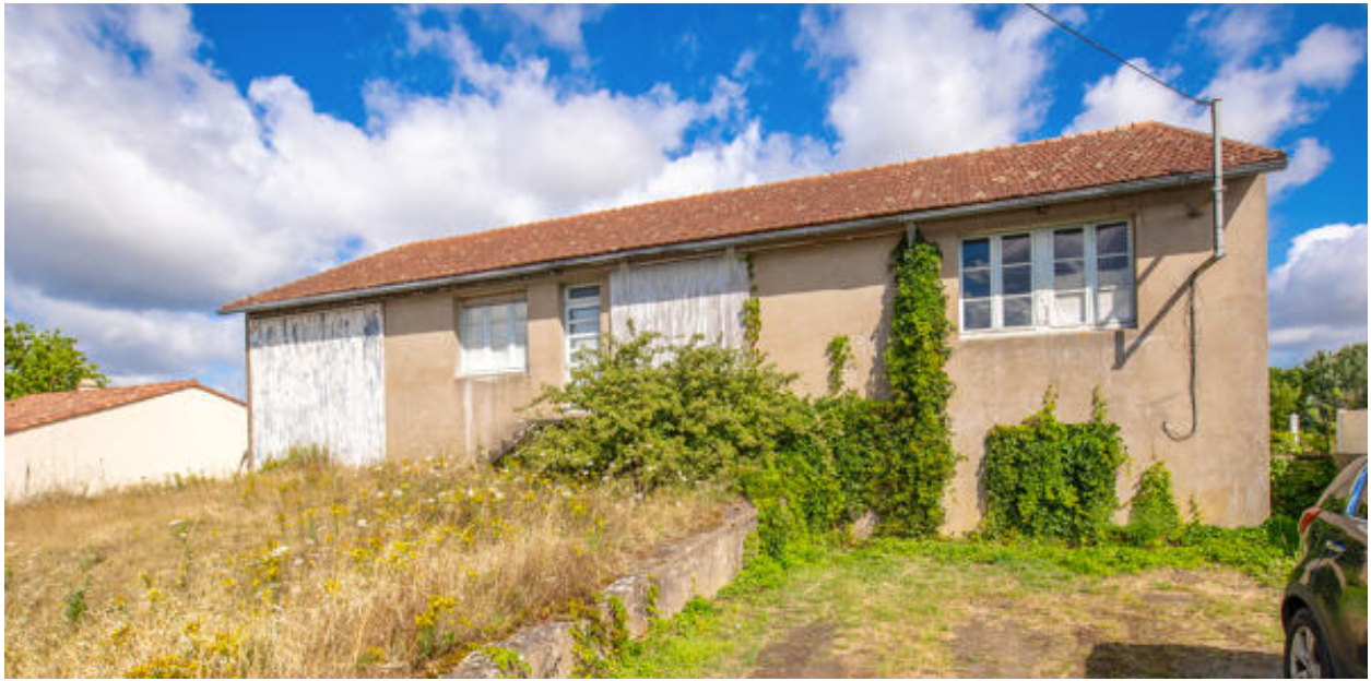
Vue générale du bâtiment d'origine et de son quai.
