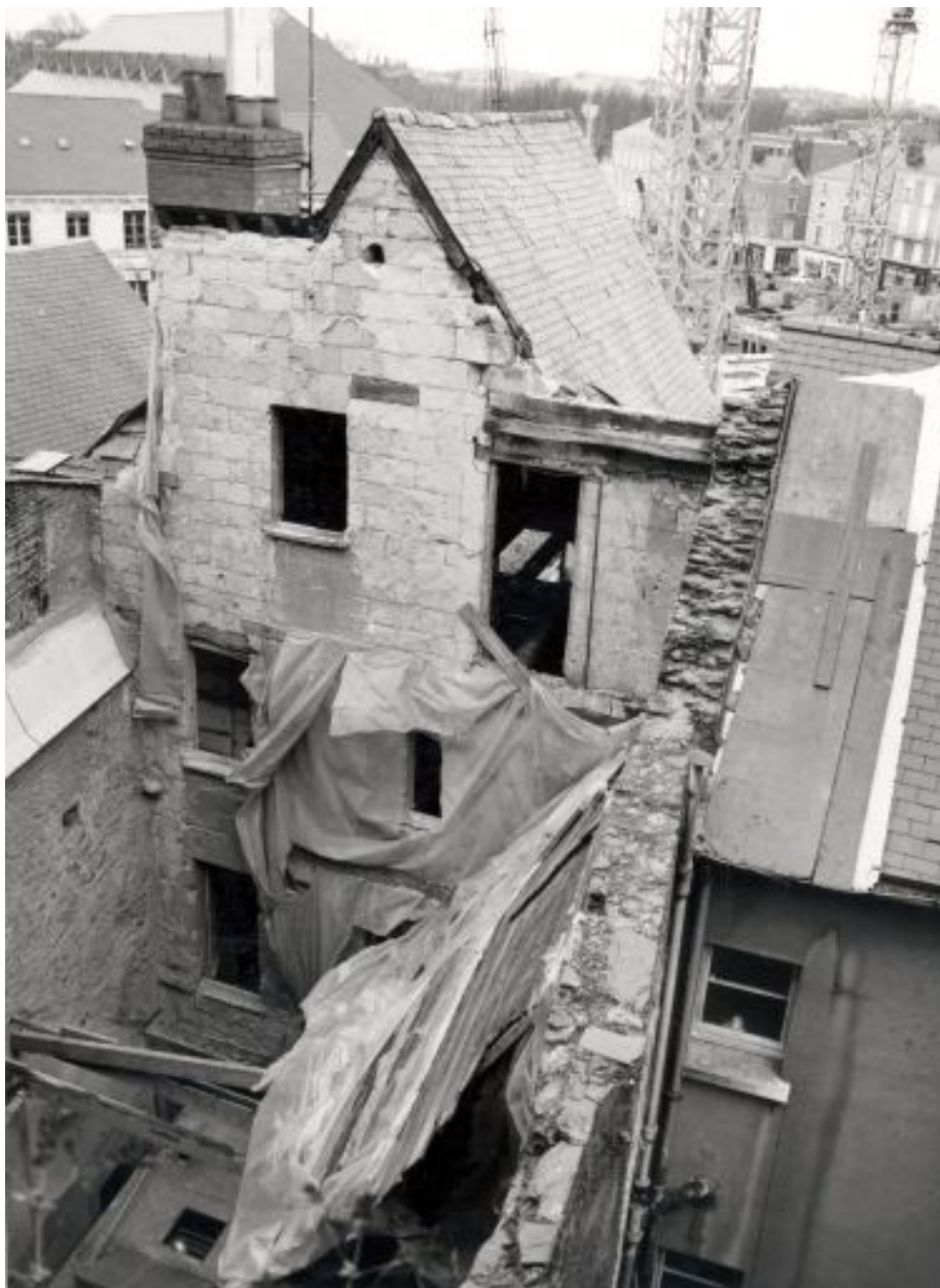
Elévation postérieure du 1er corps de logis, seul subsistant.
