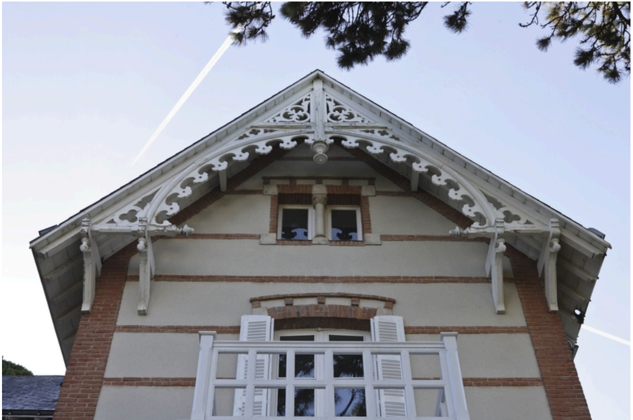
Pignon de la façade antérieure.
