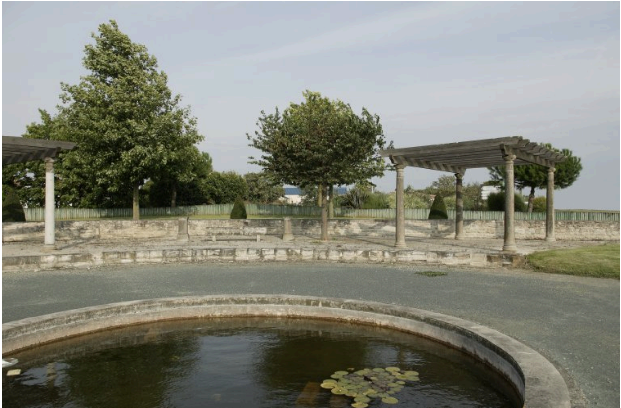
Eléments de la pergola déplacée dans un rond-point, route de Fontenay-le Comte.
