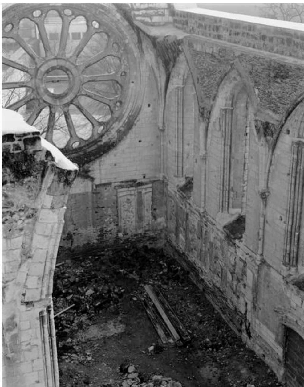
Abbatiale, choeur : élévations intérieures est et sud, vue partielle.
