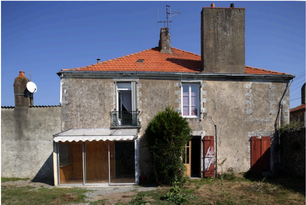
La façade sud.
