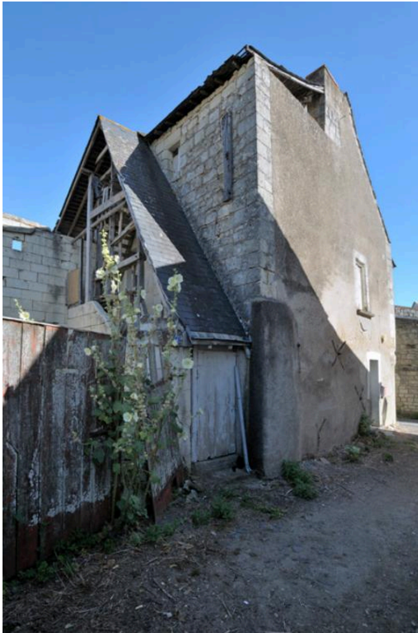
Pignon sud. Vue d'ensemble.
