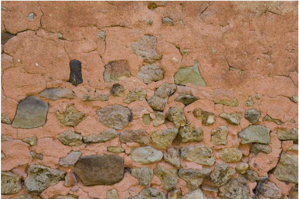
Le Petit Verger, étable. Maçonnerie de moellons enduits à chaux et sable ferrugineux des carrières de Sables (La Davière).
