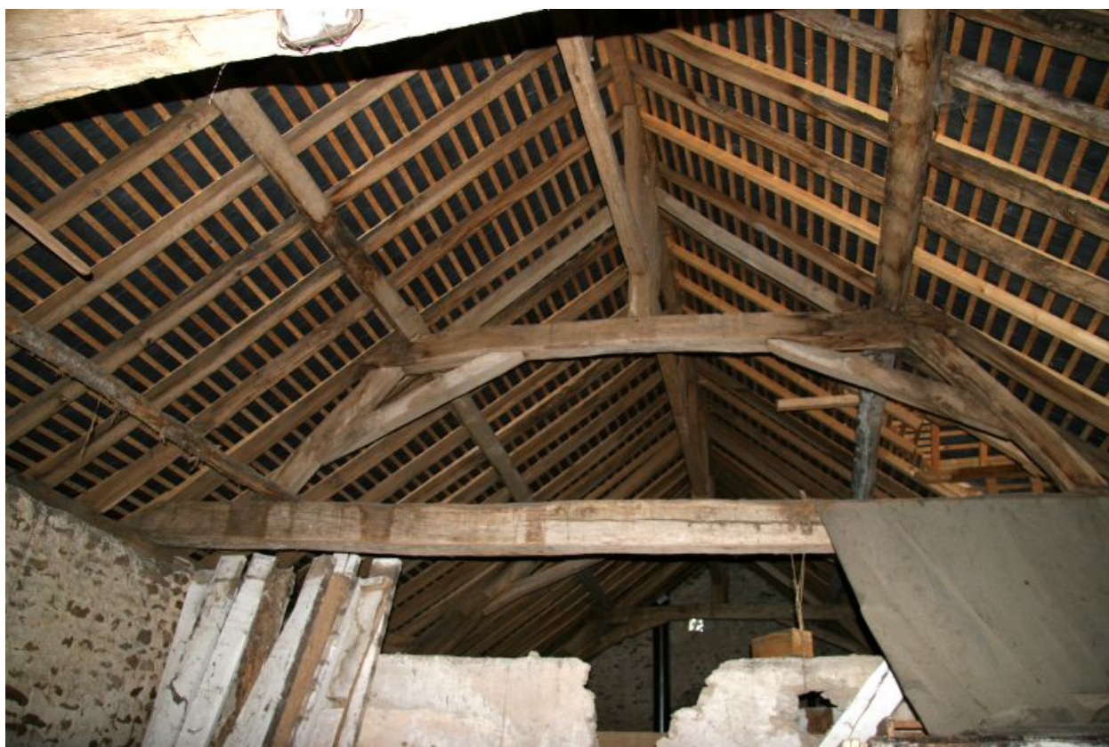
La grange : la charpente.
