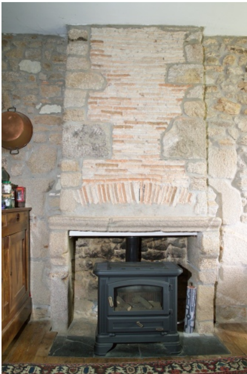
Vue de la cheminée à consoles.
