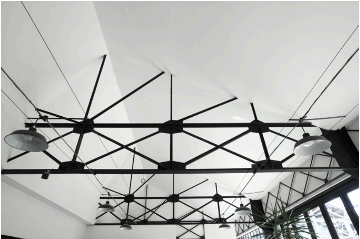
Détail de la charpente métallique.
