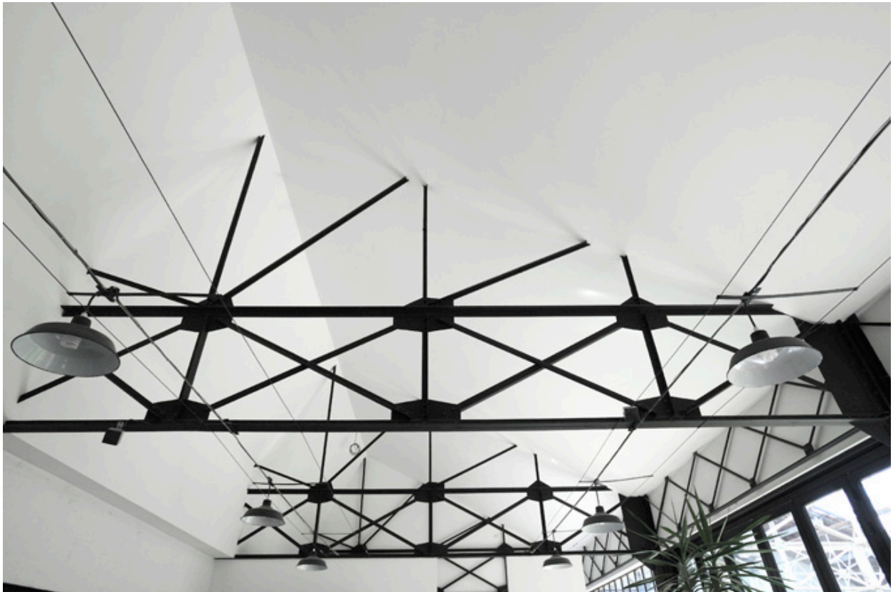
Détail de la charpente métallique.
