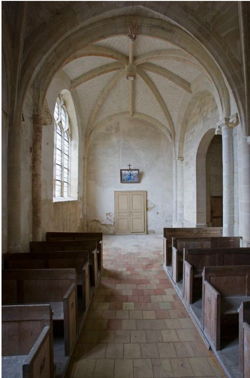
Travée 1 du bas-côté sud
