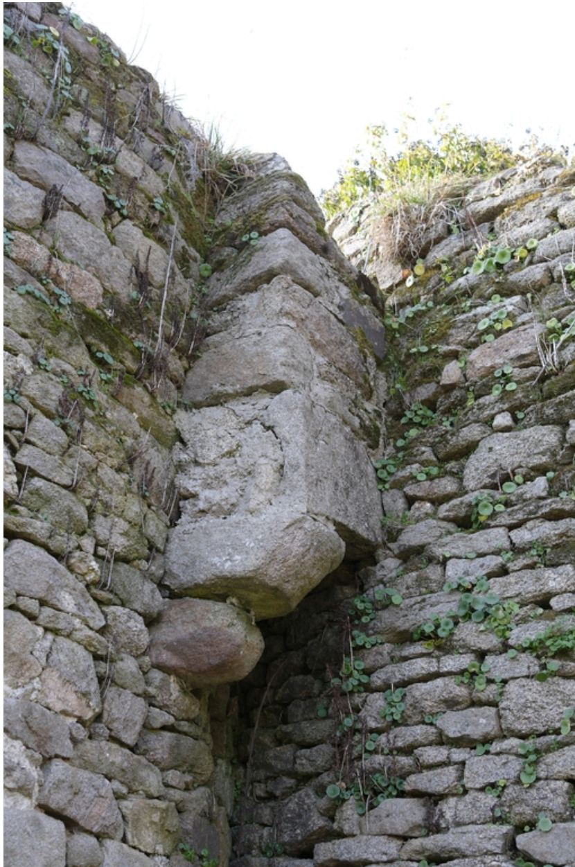
Portail d'entrée. Tour nord. Détail du conduit de latrines.
