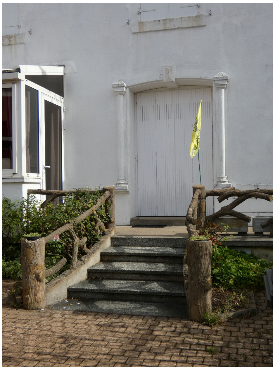
La porte à droite du rez-de-chaussée, son décor et son escalier en faux bois de ciment.
