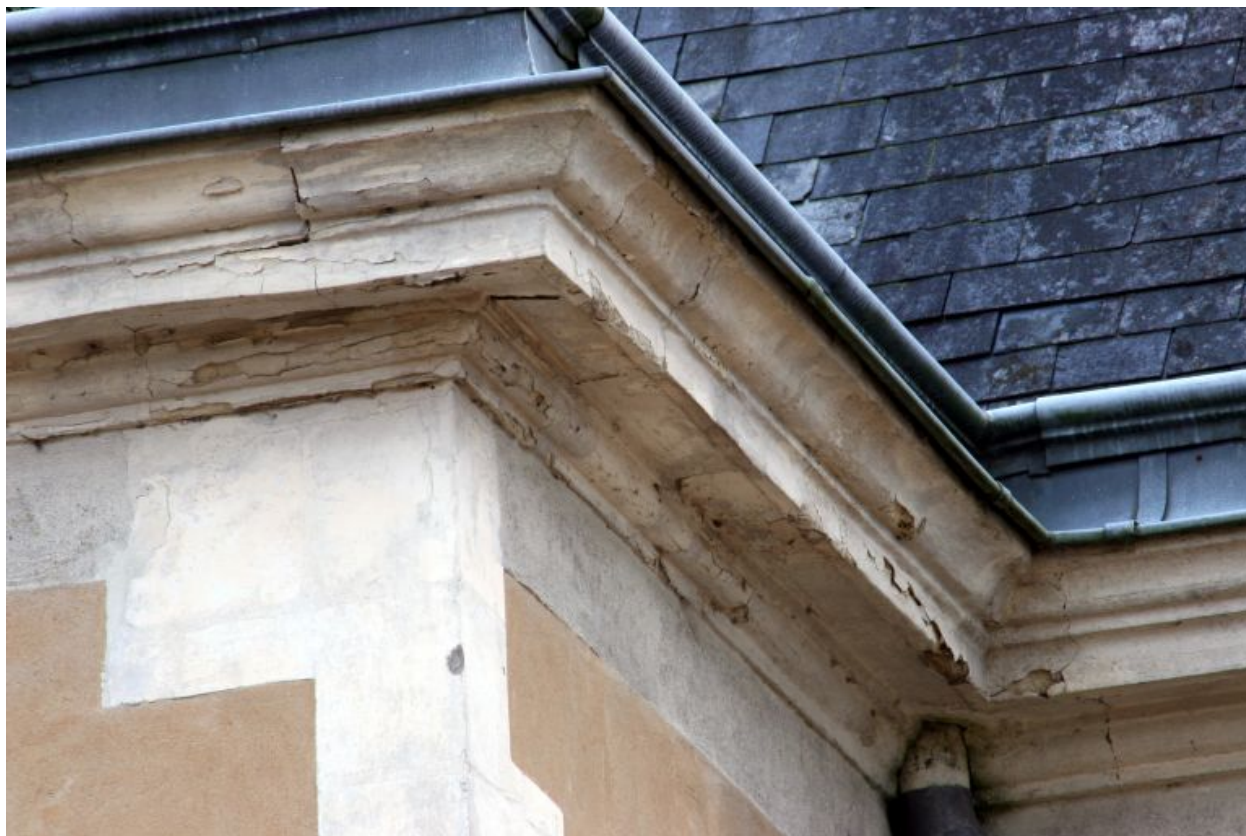
Façade sur la cour, détail : la corniche.
