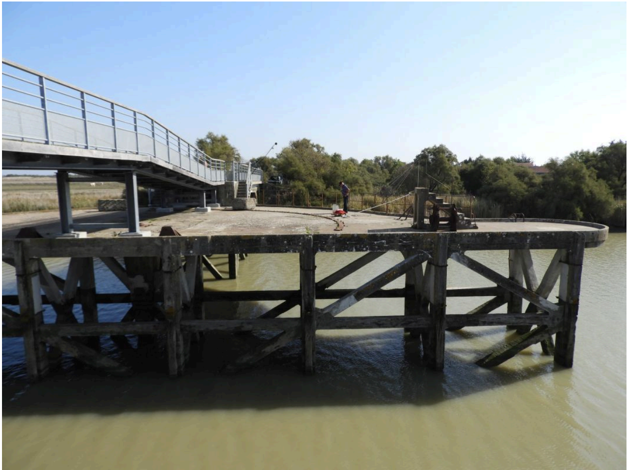
Eperon de la rive gauche du pont, côté aval.
