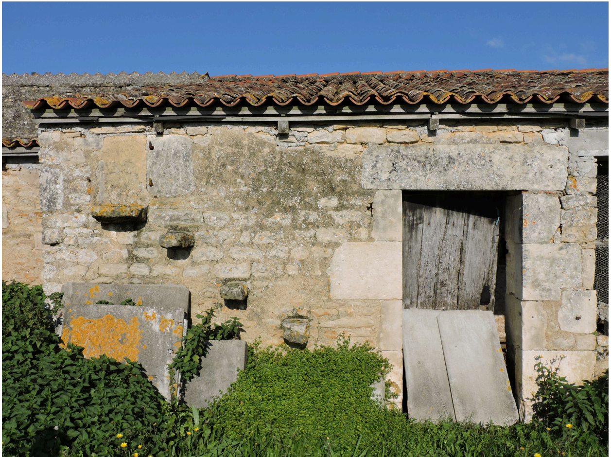
Détail du poulailler, avec escalier extérieur pour les volailles.
