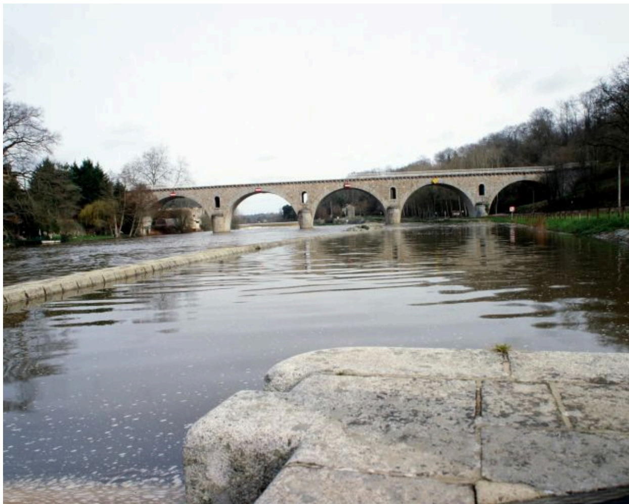
Le pont de Rochefort, reliant les communes d'Andouillé et de Montflours.
