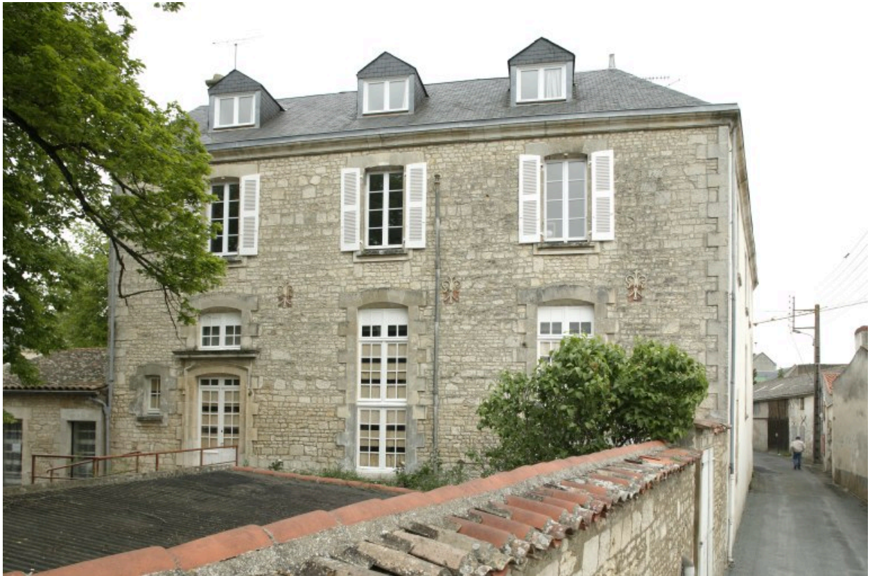
Petite aile en retour de l'aile est (vue prise de la rue de l'Asile).
