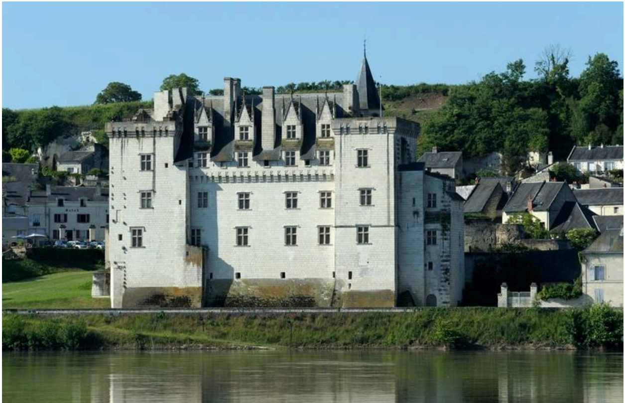
Vue générale de la façade nord, sur Loire
