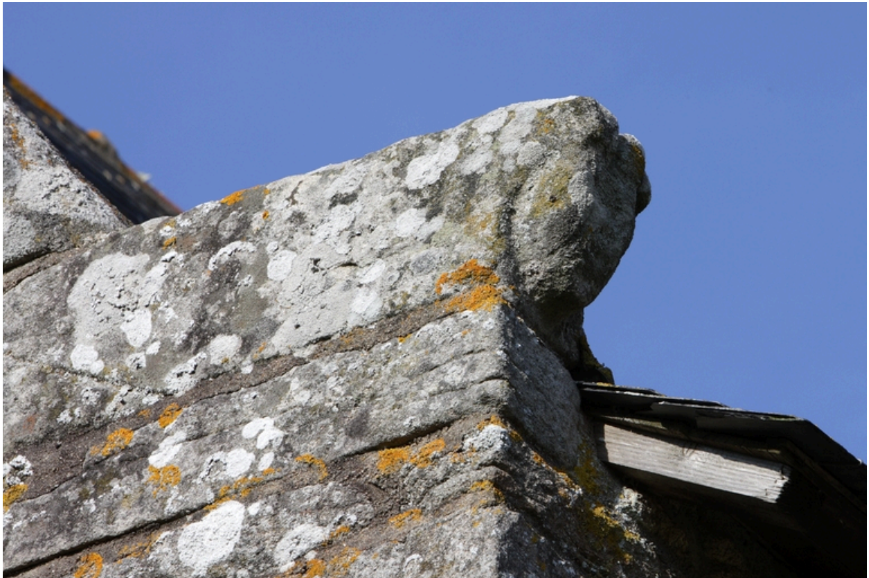
Aile ouest. Détail de la crossette sculptée sur le mur pignon sud-ouest
