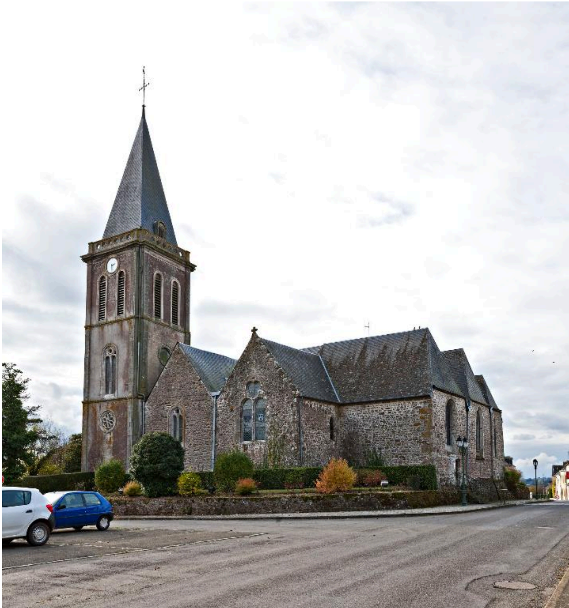
Vue d'ensemble de trois quarts depuis le nord-est.
