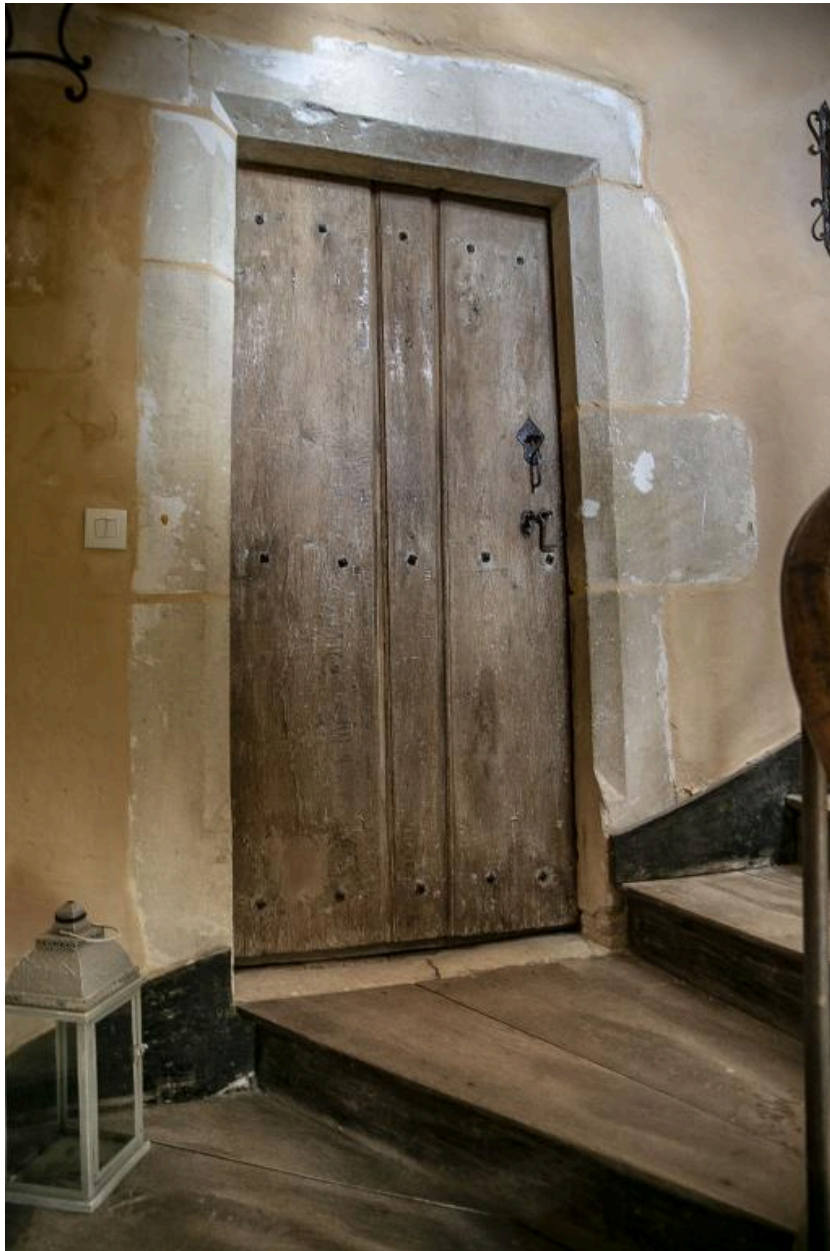
La porte de l'étage dans la tour.
