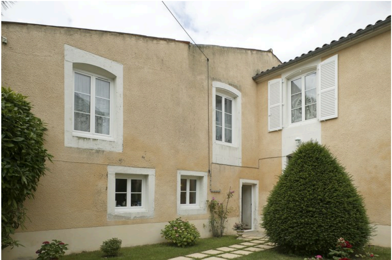
Vue des façades sur cour du logis, prises du nord de la cour.
