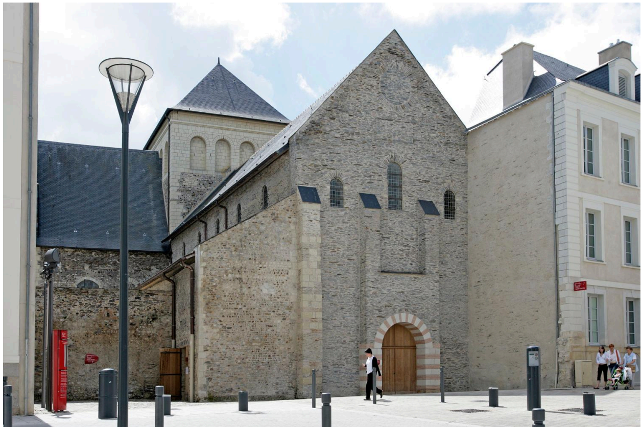
Collégiale, vue d'ensemble depuis l'ouest : la façade occidentale et la nef reconstruites.
