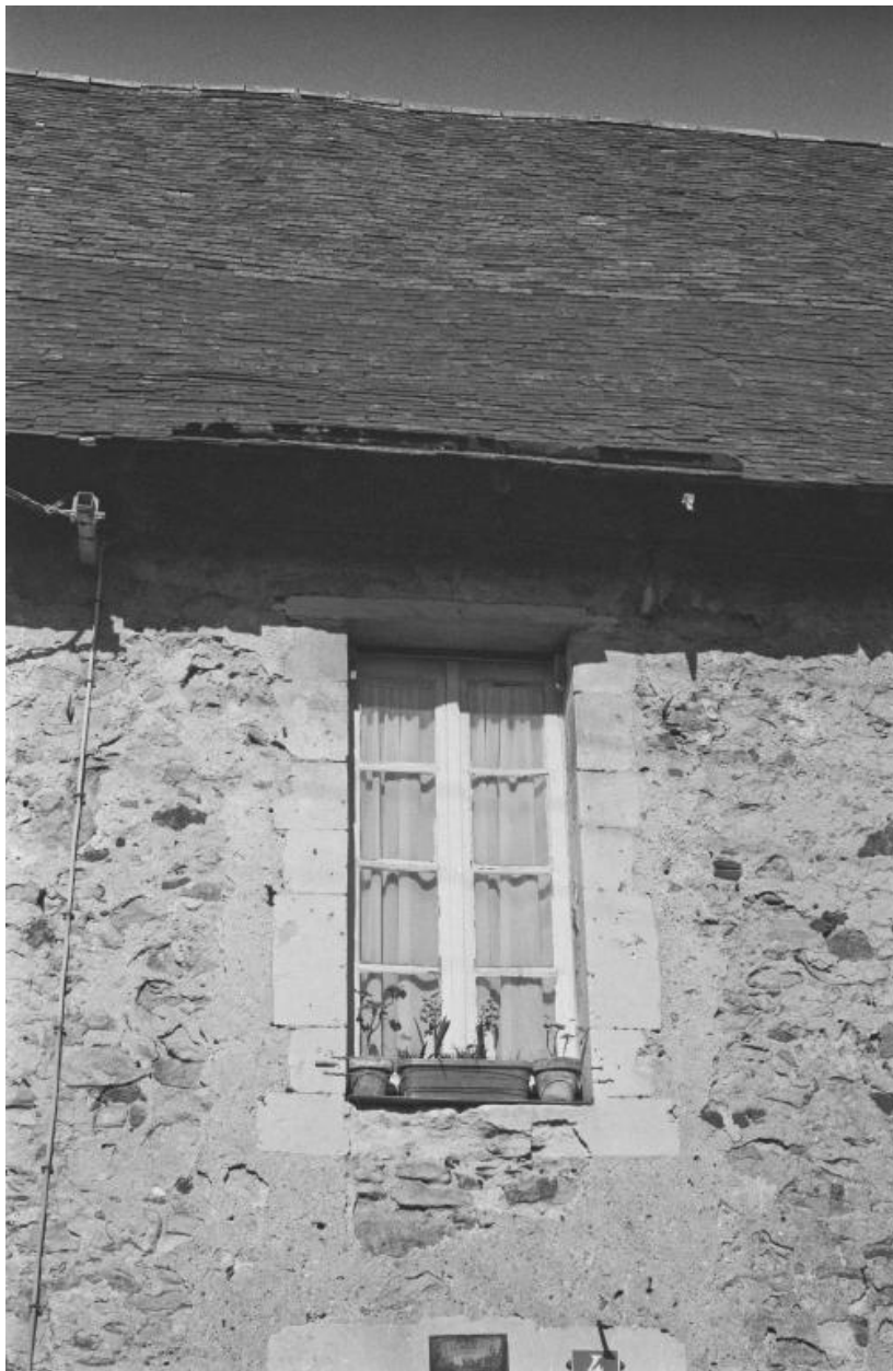
Façade sud : détail de la fenêtre de l'étage.
