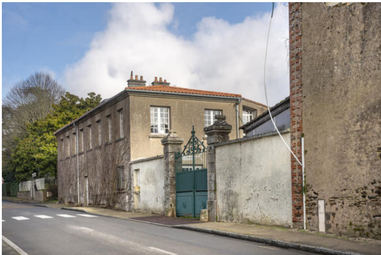
Vue générale depuis la rue de Sèvre-et-Maine.
