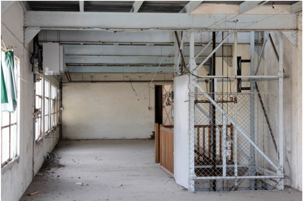
Escalier et monte-charge, du bâtiment construit en 1948.
