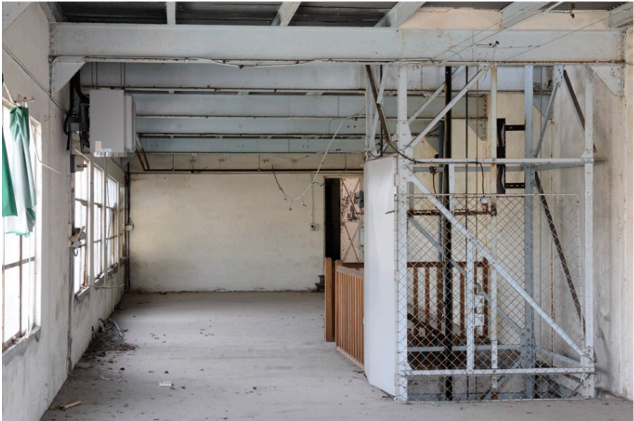
Escalier et monte-charge, du bâtiment construit en 1948.
