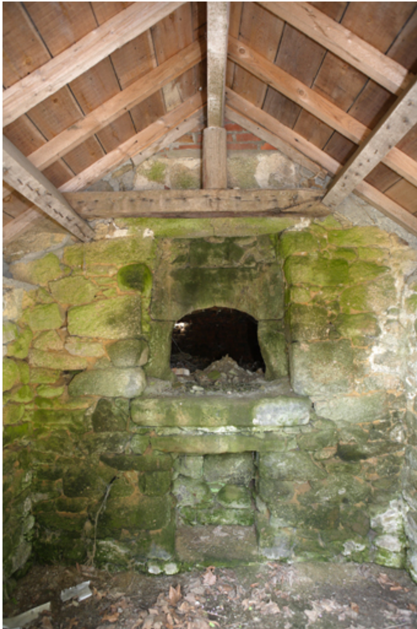
Cour. Détail de l'intérieur du four à pain.
