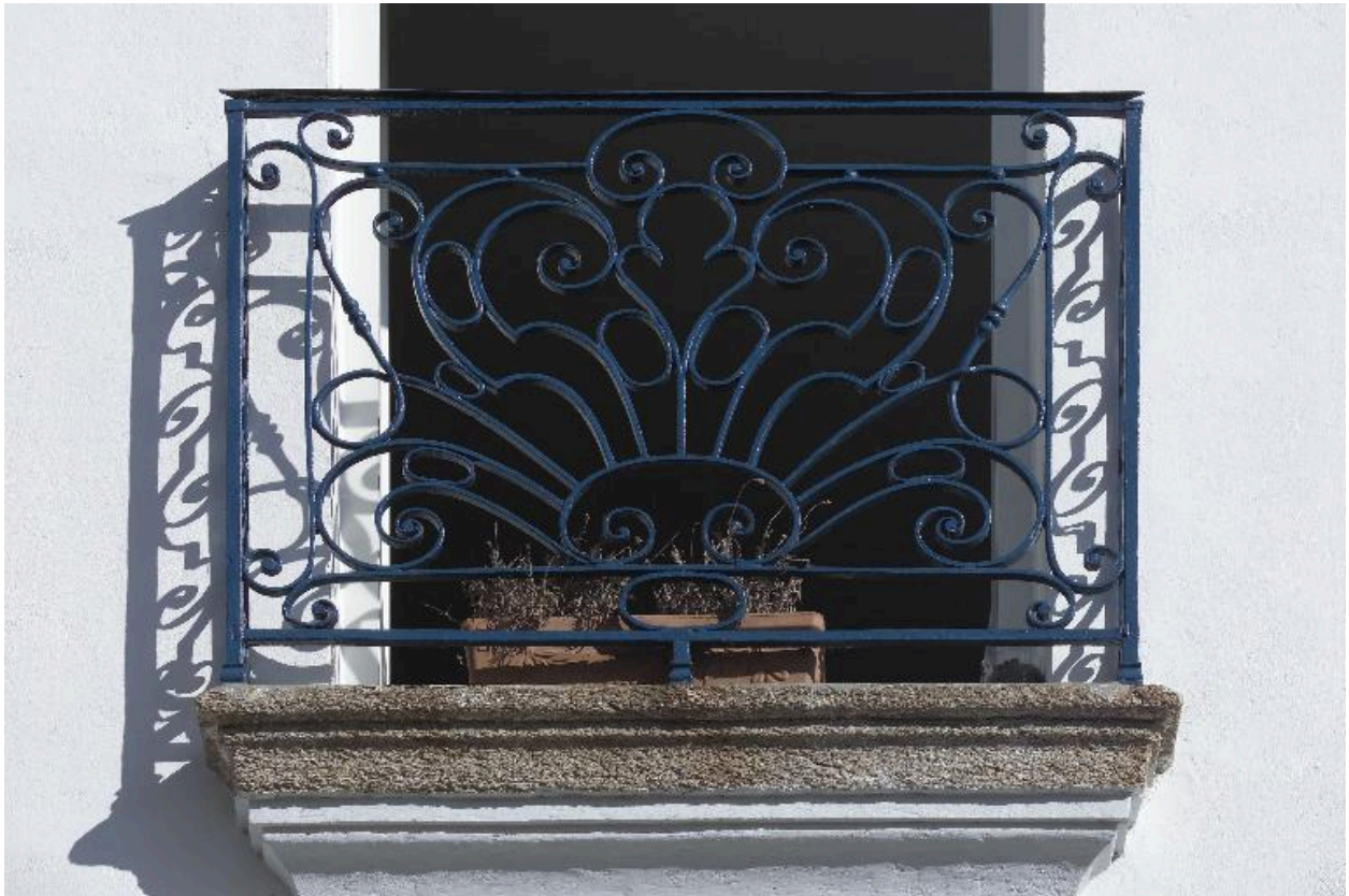
La façade sur la rue, détail d'un des balcons.
