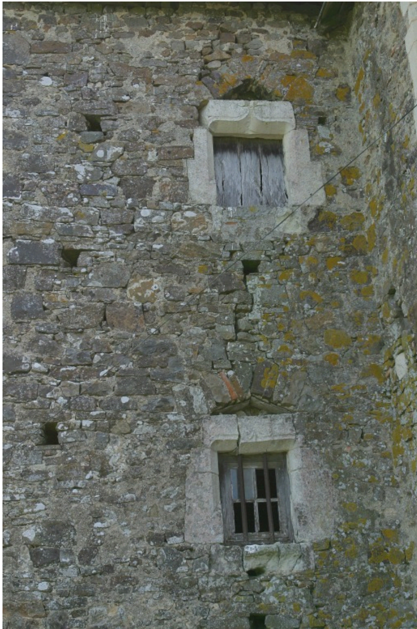
Le logis. Détail de l'élévation postérieure : les ouvertures du mur ouest de la tour d'escalier.
