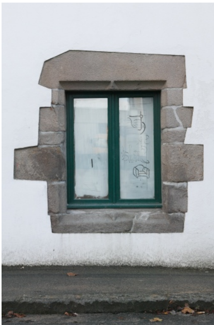
détail de la fenêtre à meneau et traverse.
