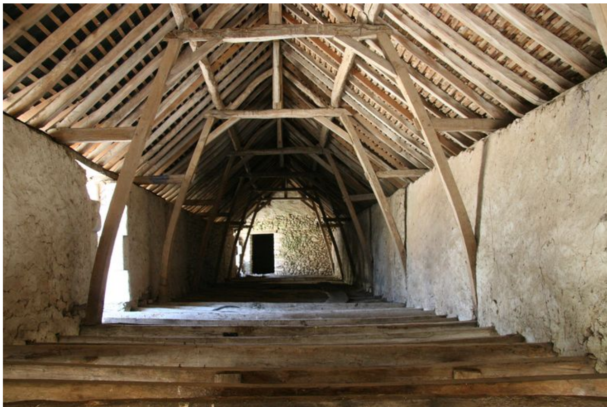
Grands communs, aile droite : grenier à grand surcroît.
