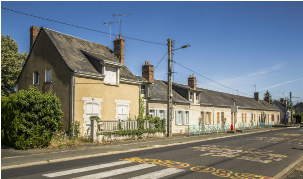
Vue des logements ouvriers construits en 1824 face à l'usine et modifiés au milieu du XXe siècle.
