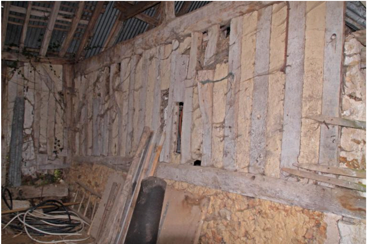
Etable : détail du mur pignon à pan de bois et tochis.
