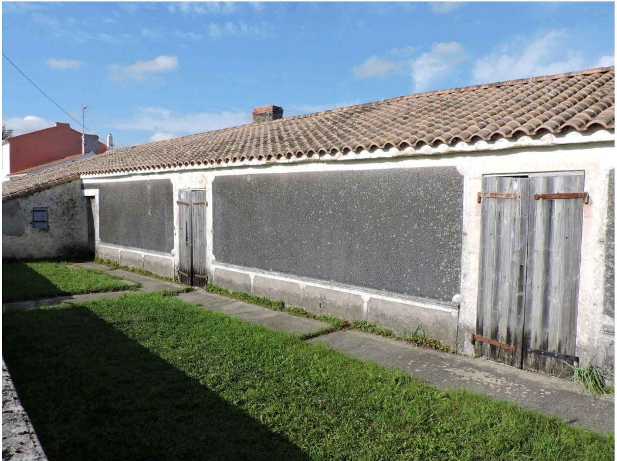
Maison en simple rez-de-chaussée, rue des Ponts.
