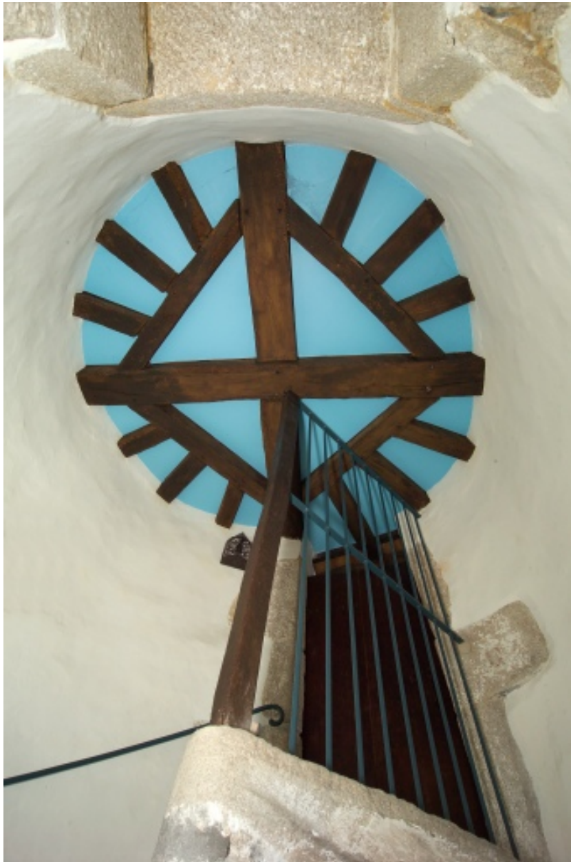
Plafond de la tour d'escalier.
