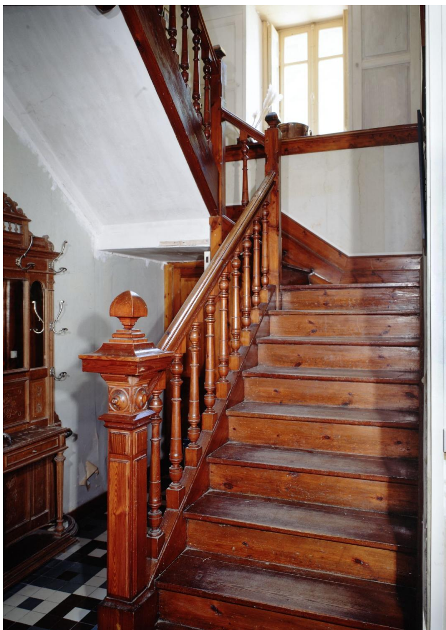
Escalier en pitchpin.
