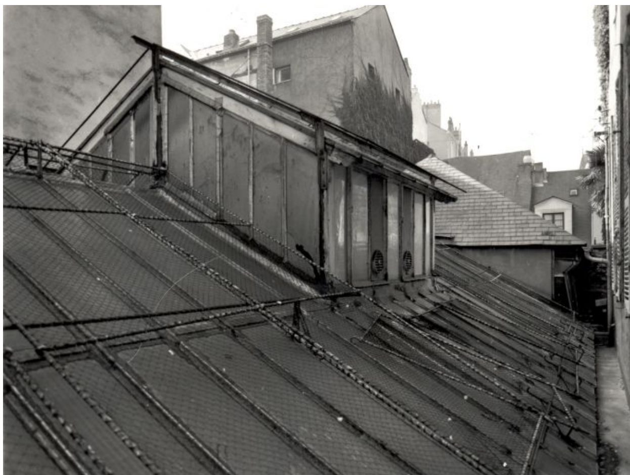
Bâtiment en rez-de-chaussée : vue partielle de la couverture, partie postérieure.
