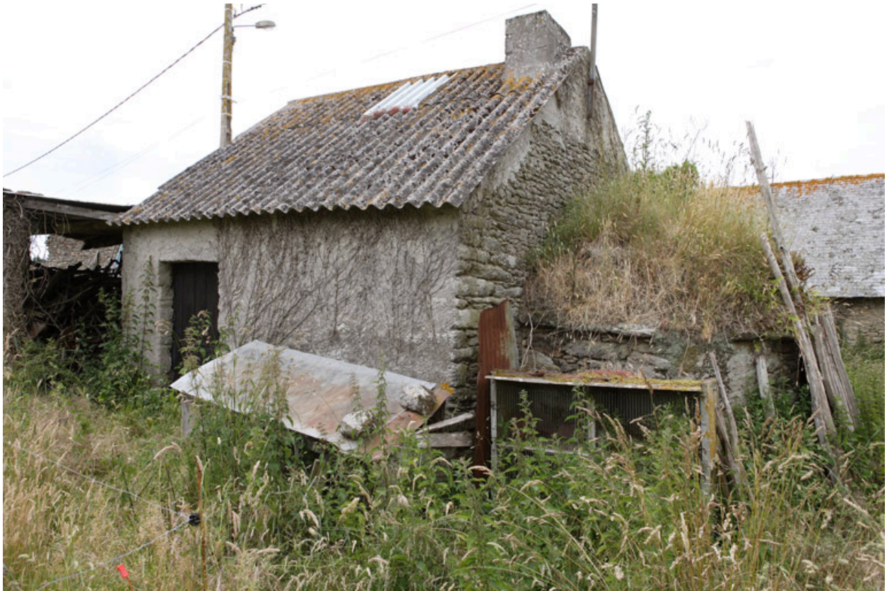
Fournil. Vue depuis le nord-est.
