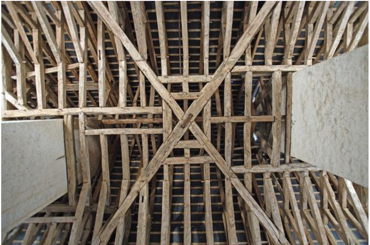
Le grand comble et sa charpente, enrayure centrale.
