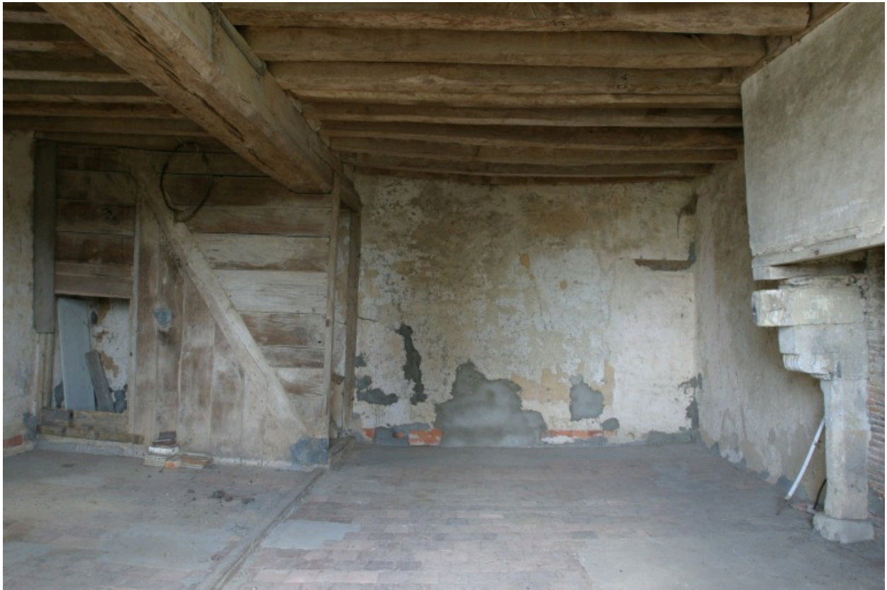
Rez-de-chaussée surélevé. La pièce 1B vue depuis l'est.
