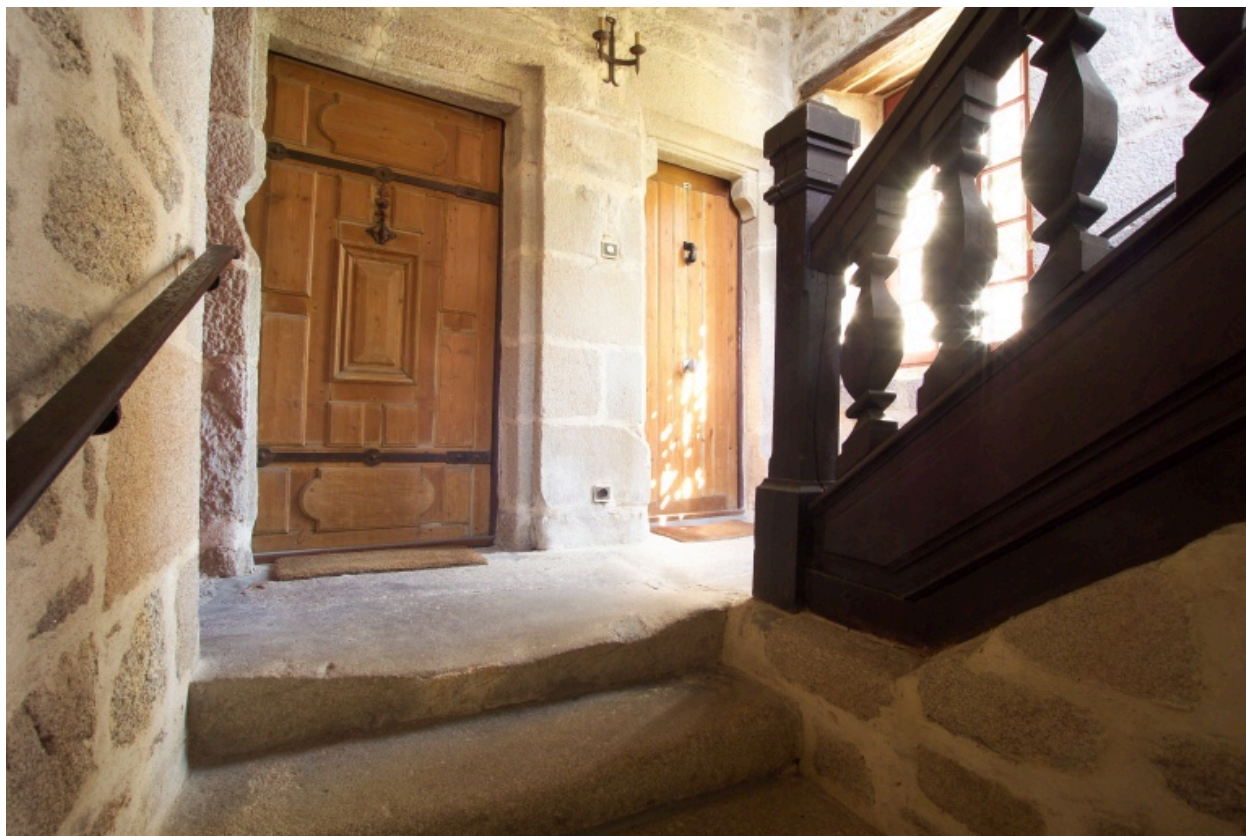
Cage d'escalier, vu du palier du premier étage.
