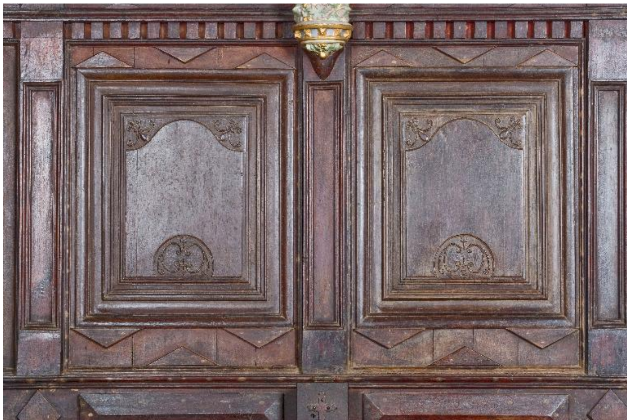
Panneaux en remploi dans la partie centrale des lambris du mur sud de la nef.
