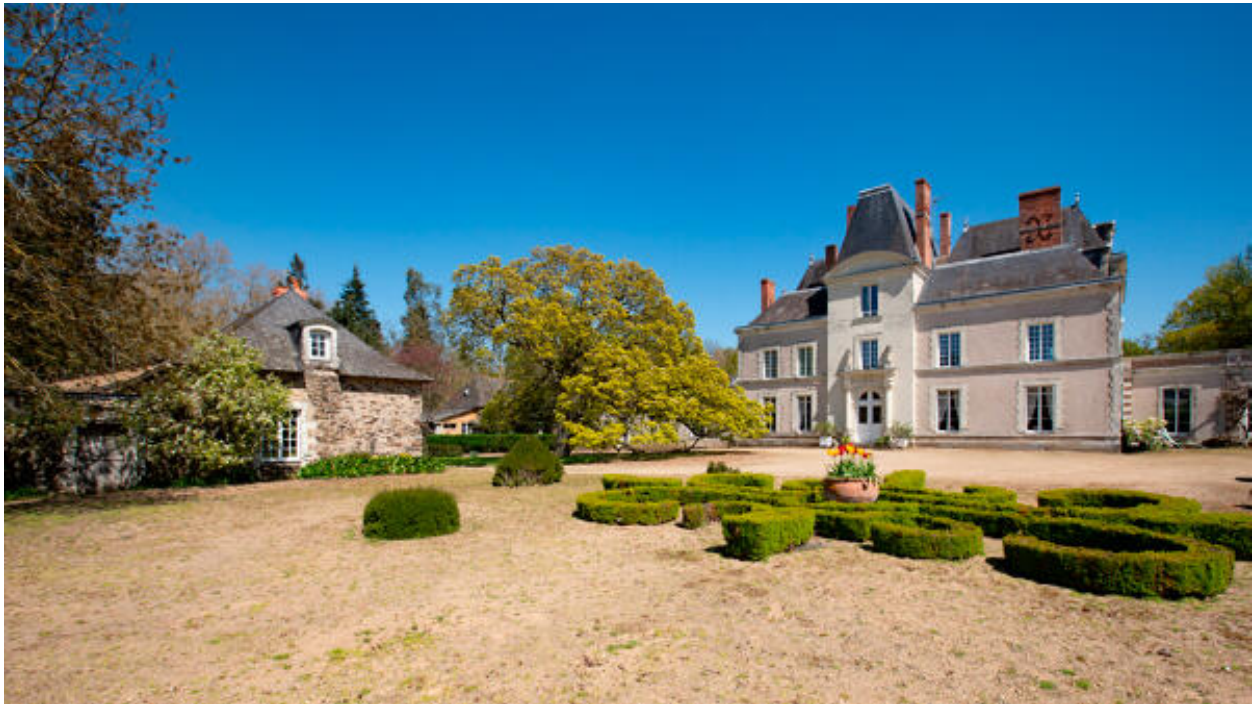
L'élévation antérieure et le parterre, côté Mayenne.
