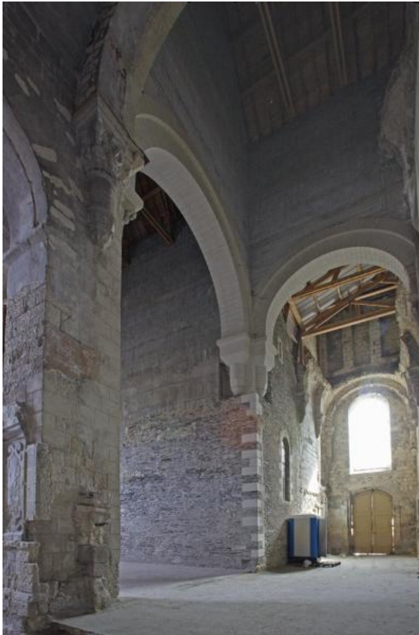
Eglise : transept, vue d'ensemble en axe nord-sud, avec l'entrée du chœur à gauche.
