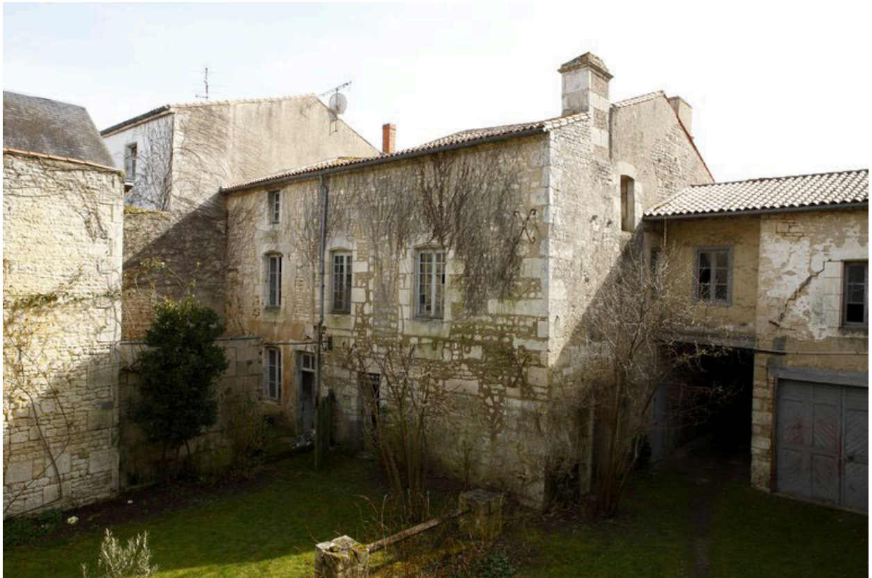
Façade arrière de la maison. A droite, l'entrée du n° 3.
